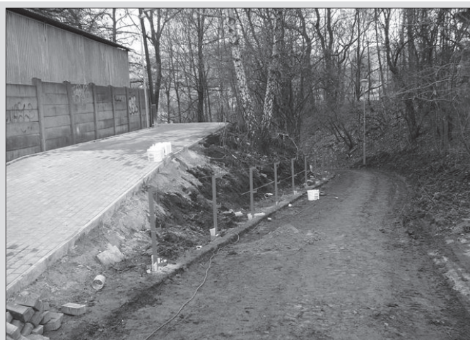
Již nevyhovující rozbitou cestu nahradí osvětlený bezbariérový chodník se zábradlím, který naváže na východ z tunelu.
